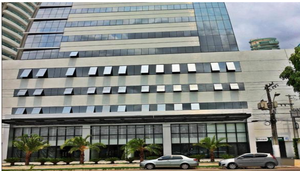
Figura 9 - Edifício Quadra Corporate – Fachada Principal
