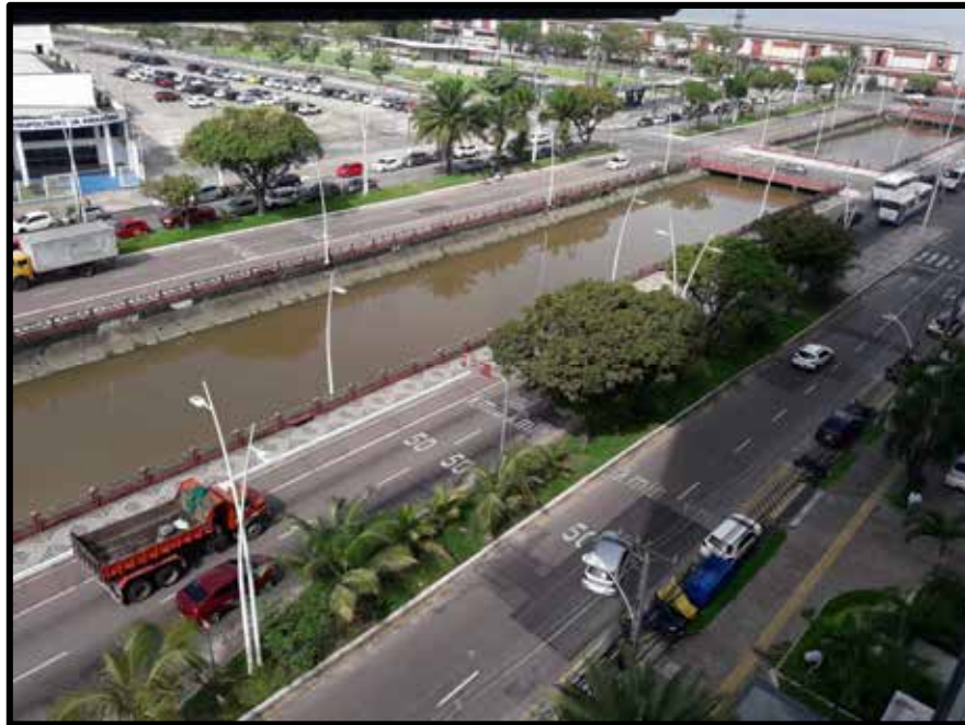
Vista da sala do 7º pavimento. Fonte: Dalton Santiago
