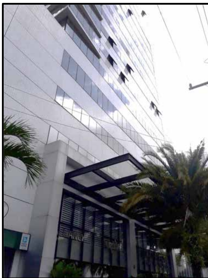
Fachada do prédio. Fonte: Dalton Santiago
