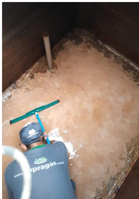
Figura 7 - Cisterna finalizando a limpeza
