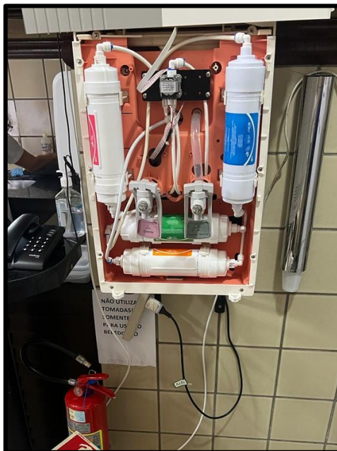
Figura 4 - Substituição dos elementos filtrantes no purificador instalado na copa do 3º andar
