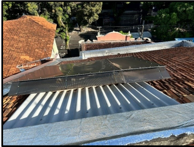
Figura 5 - Impermeabilizações de Cobertura e Estrutura em Policarbonato nos Shafts
