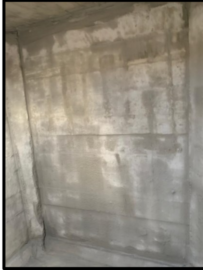
Figura 11 - Impermeabilização dos reservatórios de água – Caixa d'água
