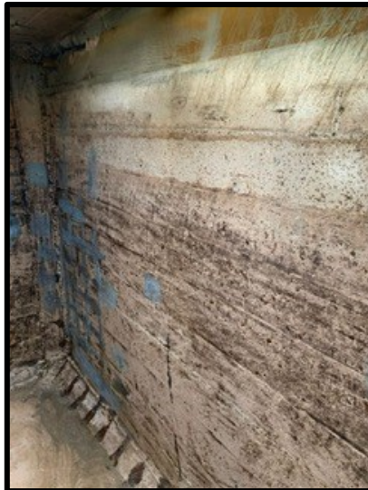
Figura 12 - Impermeabilização dos reservatórios de água - Cisterna
