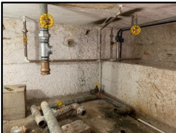
Figura 10 - Substituição de barrilete da coluna de combate à incêndio
