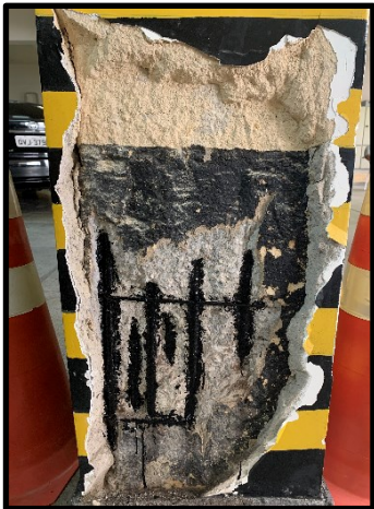
Figura 6 - Recuperação de pilares da garagem, com tratamento das ferragens
